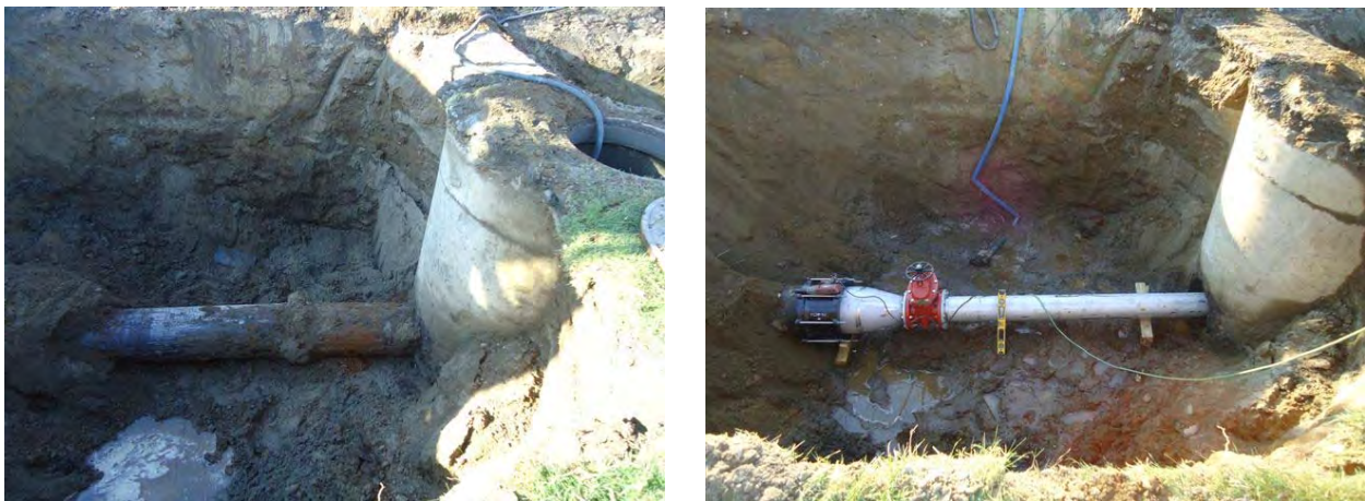
Figure 16-1 : Aménagement d'un débitmètre sur une conduite à diamètre réduit
