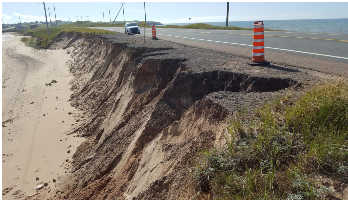
FIGURE 1 : DOMMAGES OBSERVÉS À LA SUITE DE L'OURAGAN DORIAN – POINTE-AUX-LOUPS F0107 (CÔTÉ LAGUNE)
