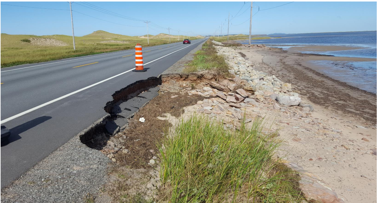
FIGURE 3 : DOMMAGES OBSERVÉS À LA SUITE DE L'OURAGAN DORIAN – F0122 (CÔTÉ LAGUNE)
