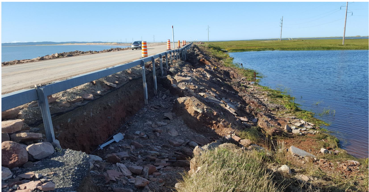
FIGURE 2 : DOMMAGES OBSERVÉS À LA SUITE DE L'OURAGAN DORIAN – F0103 JETÉE DU DÉTROIT (CÔTÉ LAGUNE)
