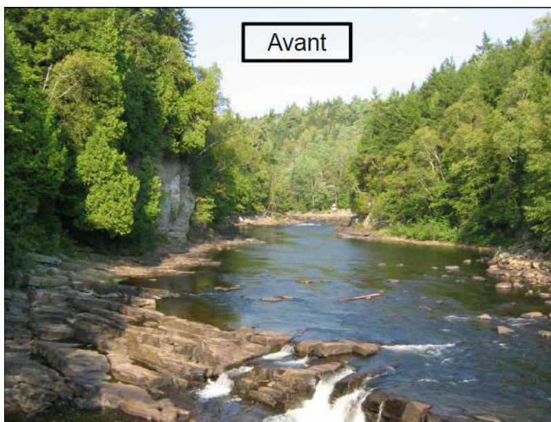
FIGURE 2 : VUE VERS L'EMPLACEMENT DU DÉVERSOIR PROJETÉ À PARTIR DU PONT MESTACHIBO
