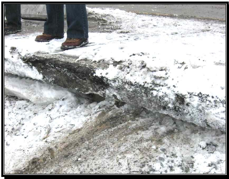
FIGURE 5 : ÉROSION DE LA STRUCTURE DE LA CHAUSSÉE SOUS LE PAVAGE DES RANGS DU GRAND-CHENAL ET DE LA POINTE-DU-NORD-EST (PHOTO PRISE LE 29 JANVIER 2008)
