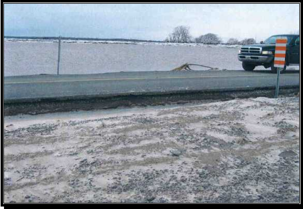
FIGURE 2 : ÉROSION DU TALUS LE LONG DE LA RIVIÈRE YAMASKA ET D'UNE PARTIE DE LA STRUCTURE DE LA CHAUSSÉE DU CÔTÉ DES CHAMPS AGRICOLES LE LONG DES RANGS DU GRAND-CHENAL ET DE LA POINTE-DU-NORD-EST (TIRÉE DU RAPPORT DE LA MUNICIPALITÉ DE YAMASKA, JANVIER 2008)
