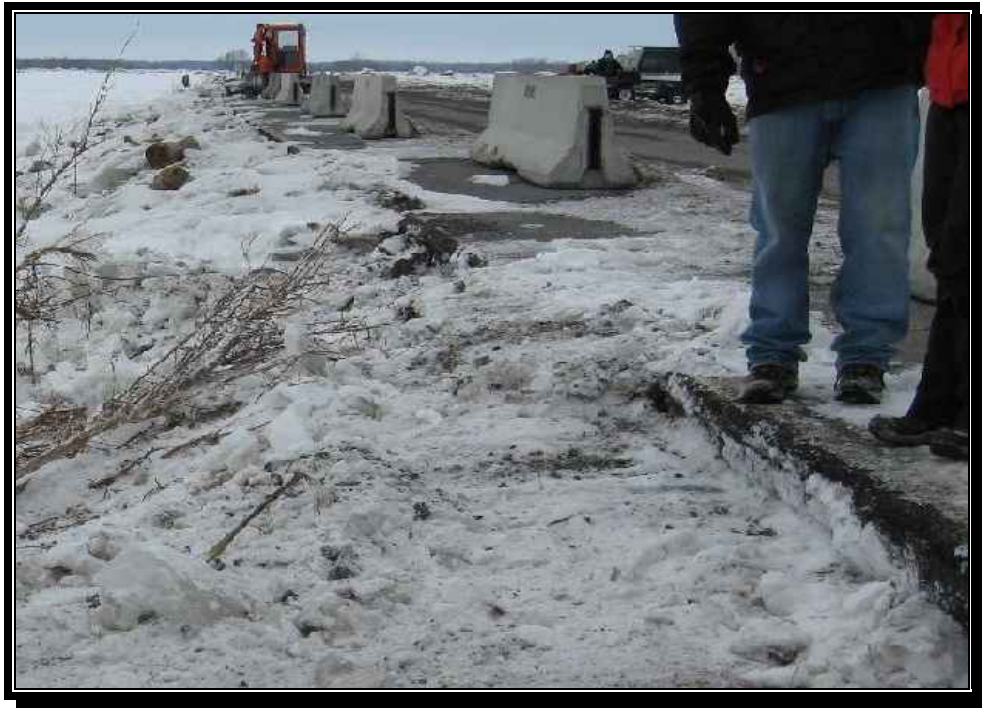
FIGURE 3 : ÉROSION DU TALUS LE LONG DE LA RIVIÈRE YAMASKA ET DE L'ACCOTEMENT DE LA VOIE PUBLIQUE LE LONG DES RANGS DU GRAND-CHENAL ET DE LA POINTE-DU-NORD-EST; VUE EN DIRECTION AVAL (PHOTO PRISE LE 29 JANVIER 2008)
