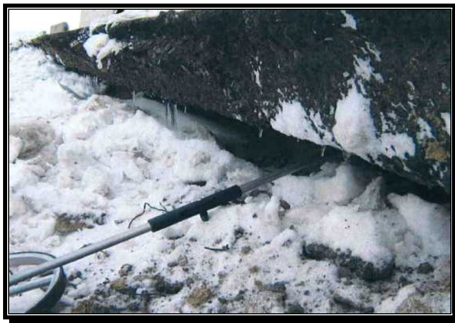
FIGURE 6 : ÉROSION DE LA STRUCTURE DE LA CHAUSSÉE SOUS LE PAVAGE (TIRÉE DU RAPPORT DE LA MUNICIPALITÉ DE YAMASKA, JANVIER 2008)
