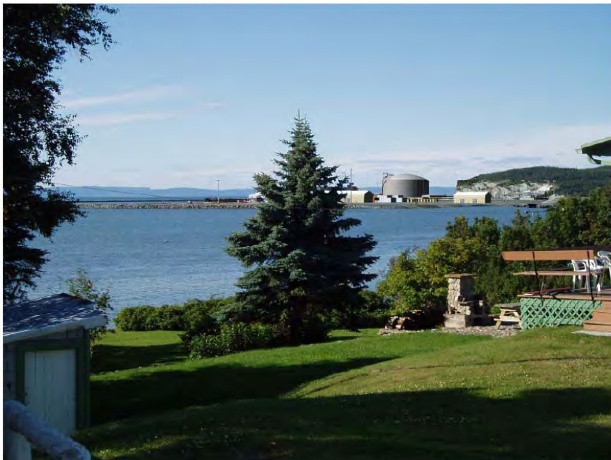
Figure 5 : Vue modélisée du point de vue 6 – Chalet sur la rive du secteur du village de la municipalité de Cacouna (la coupure de la falaise du côté du fleuve serait moins significative suite à un travail d’optimisation du plan d’aménagement limitant la superficie dynamitée, Il y a deux réservoirs, mais ces derniers sont dans le même axe d’enlignement)
