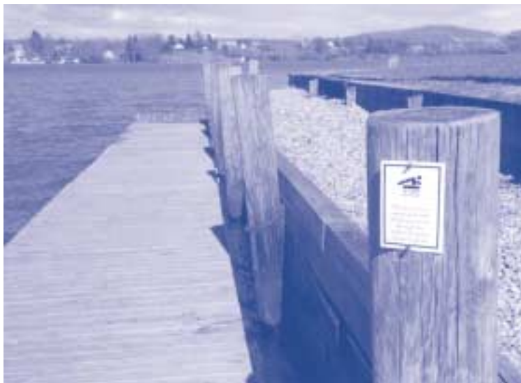
Un quai à Ticonderoga, financé par une subvention du PMVLC visant à favoriser l'accès au public.
