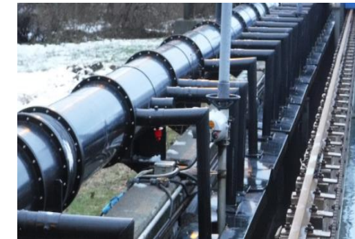
Conduite d'interception des odeurs sur les décanteurs
