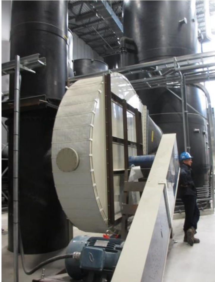
Stockage des produits chimiques à la RAEBL et dosage des produits chimiques, tours de lavage et ventilateur centrifuge moyenne pression
