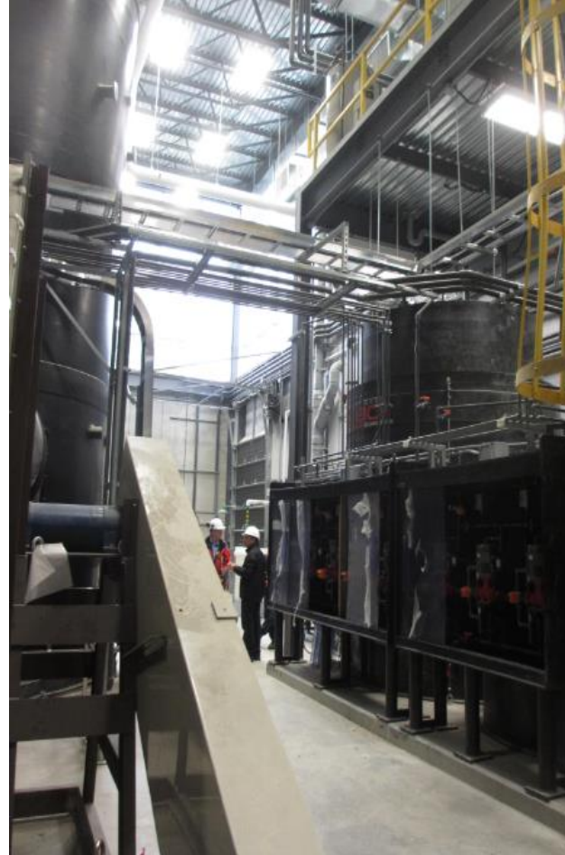
Stockage des produits chimiques à la RAEBL et dosage des produits chimiques, tours de lavage et ventilateur centrifuge moyenne pression
