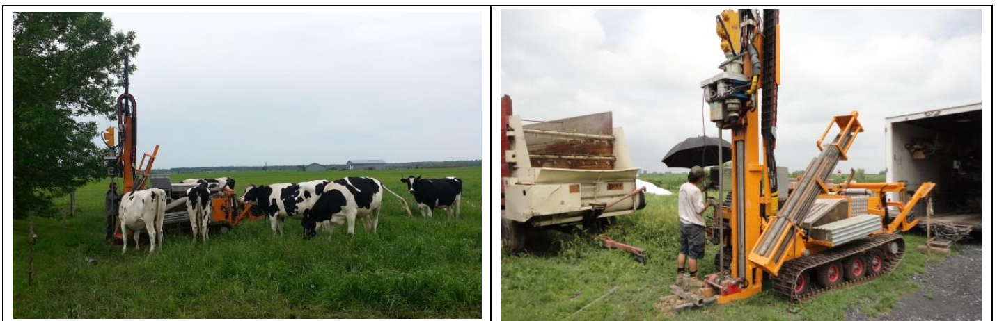
Figure 2.3 : Travaux de forages avec la foreuse Geotech 605D de l'INRS
