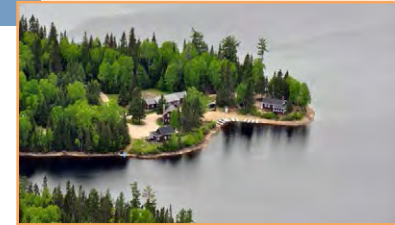
Bâtiments de la SÉPAQ au Grand lac des Îles (M.-A. Bouchard, MELCC)
