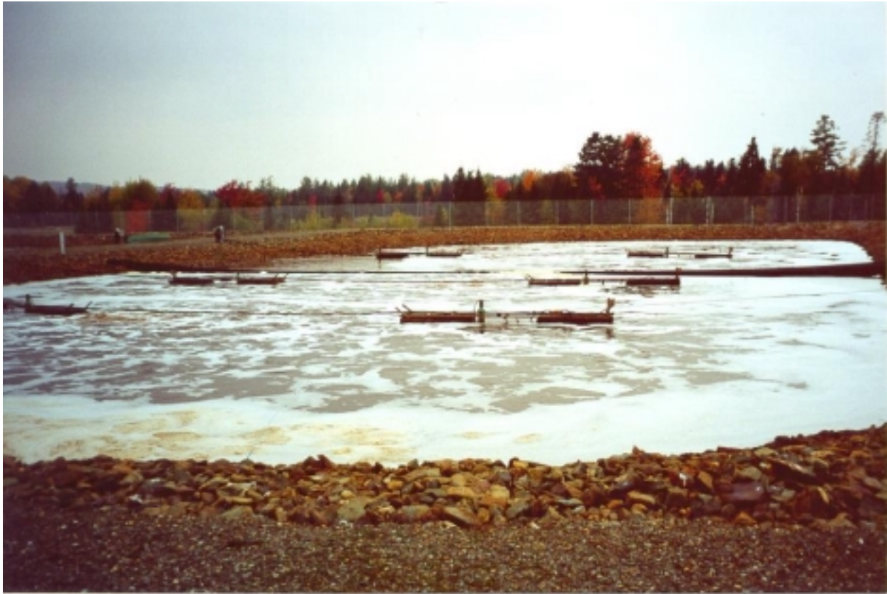
Figure 5 : Étang aéré du système de traitement du lixiviat
