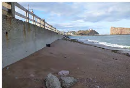
FIGURE 6 PLAGE ACTUELLE VIS-À-VIS LE MUR DE BÉTON (IMAGE TIRÉE DE BPR, 2014)
