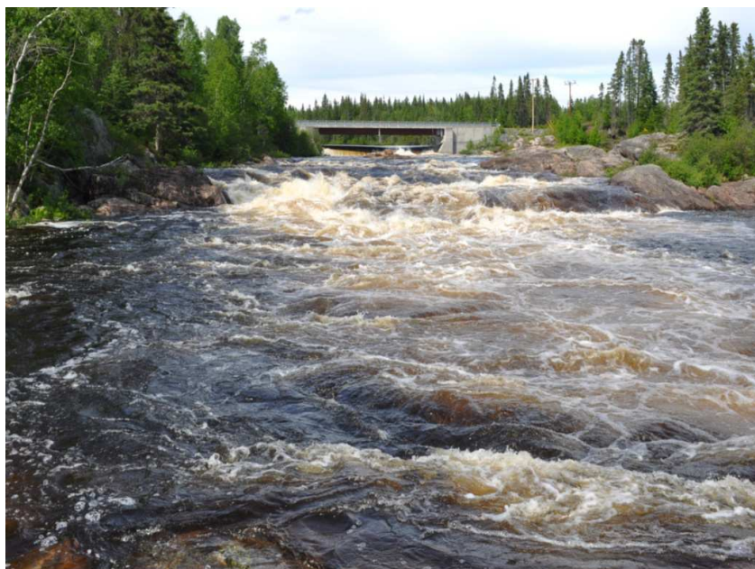
Débit de 26 m 3 /s au site de la centrale Minashtuk
