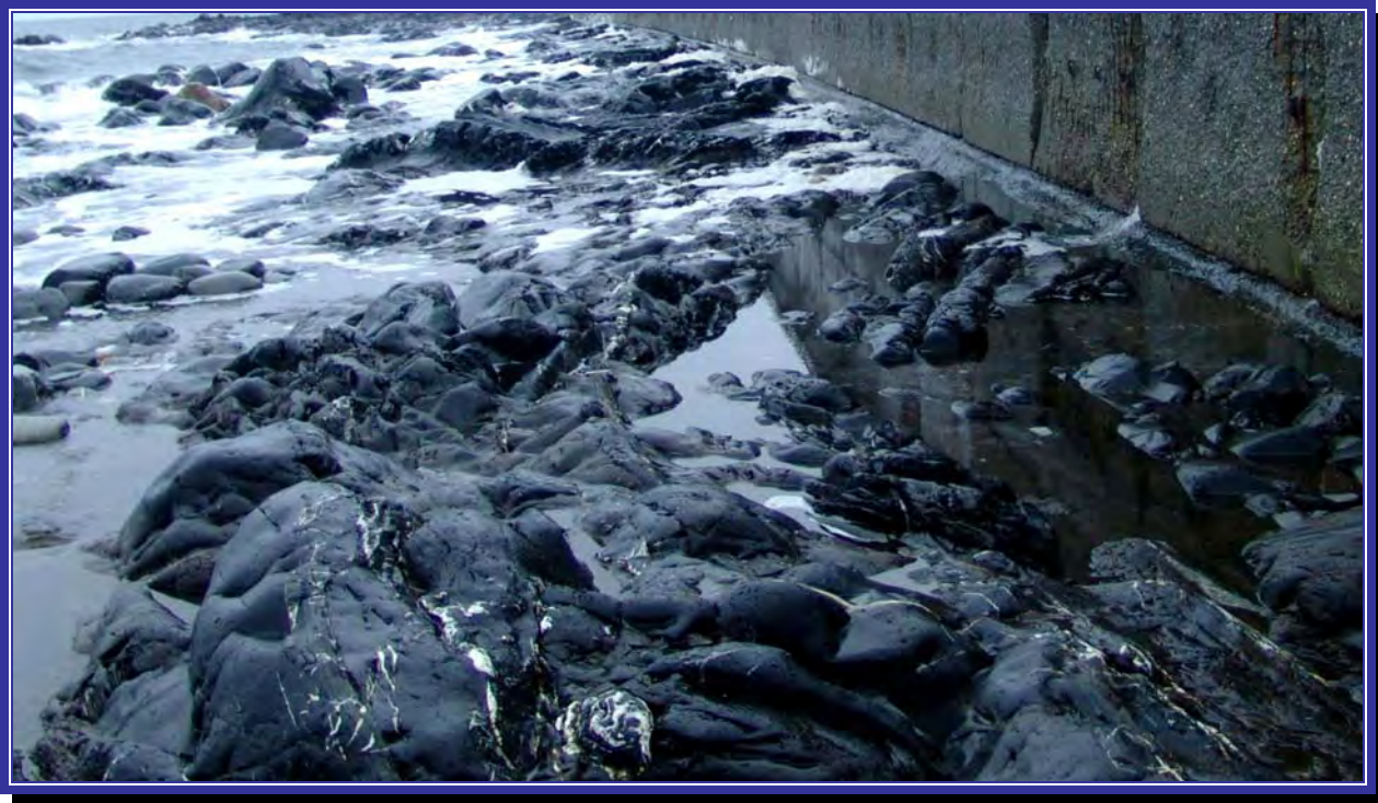
FIGURE 4 : PHOTO DU SUBSTRAT PRÉSENT AU PIED DU MUR À RECONSTRUIRE DANS LE SECTEUR OUEST (LOUIS BELZILE, MAI 2008)
