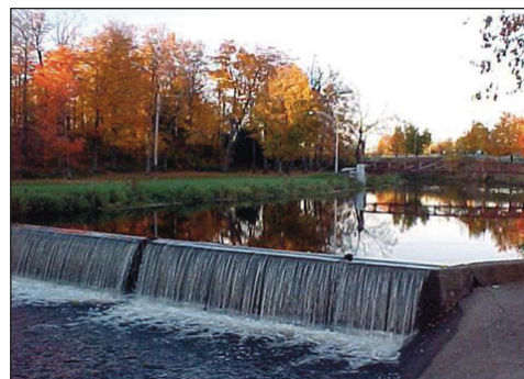
Photo 3 : En présence d'un ouvrage de retenue, la ligne des hautes eaux correspond à la cote maximale d'exploitation
