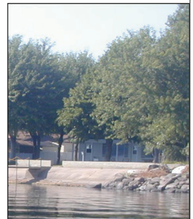
Photo 26: Utilisation du faite du mur pour déterminer la ligne des hautes eaux
