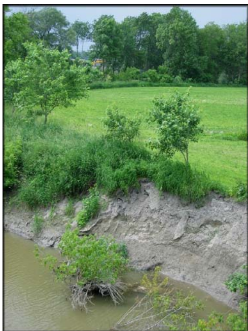
Décrochement de la rive, près du Pont couvert Grandchamp.
