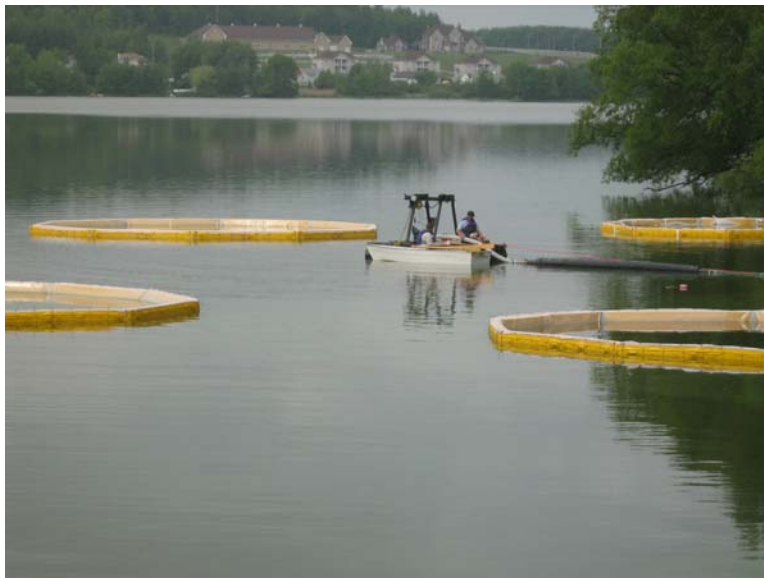
Photo 3 Équipements utilisés pour pomper les sédiments du lac Waterloo vers le Géotube®.
