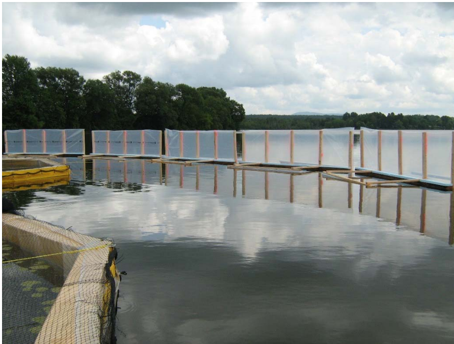
Photo 2 : Installation finale des estacades
