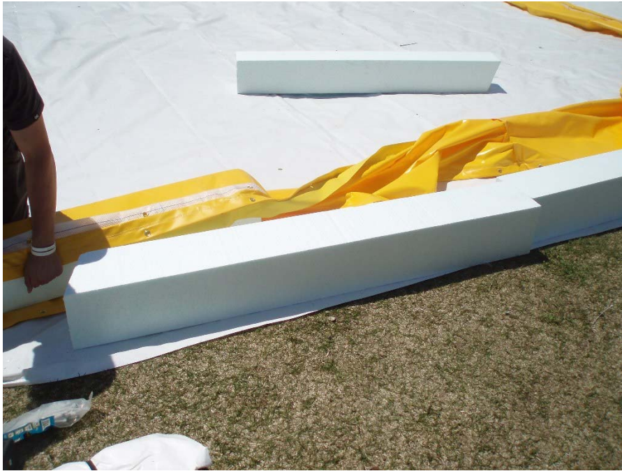
Photo 5 : Section de styromousse constituant l'anneau de flottaison
