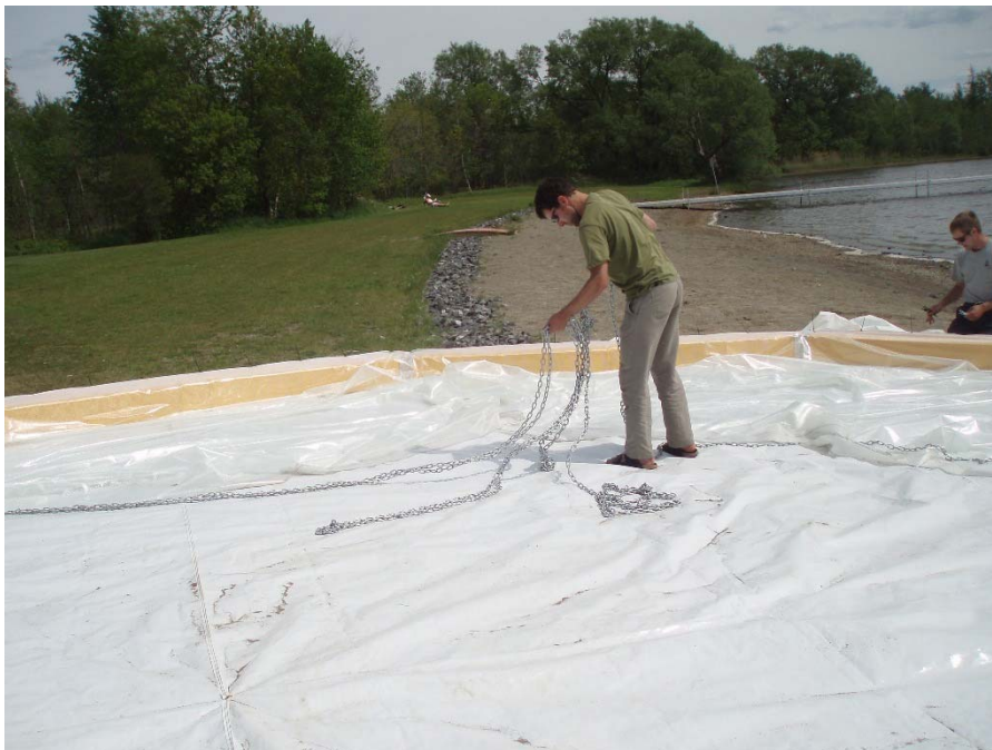
Photo 8 : Mise en place de la chaîne d'ancrage
