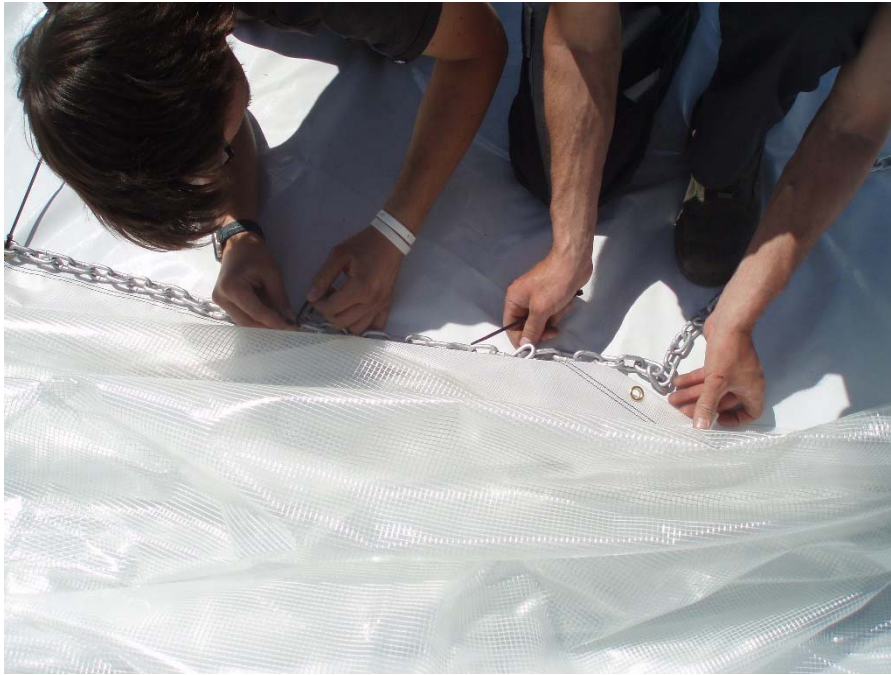
Photo 3 : Mise en place de la chaîne d'amarrage
