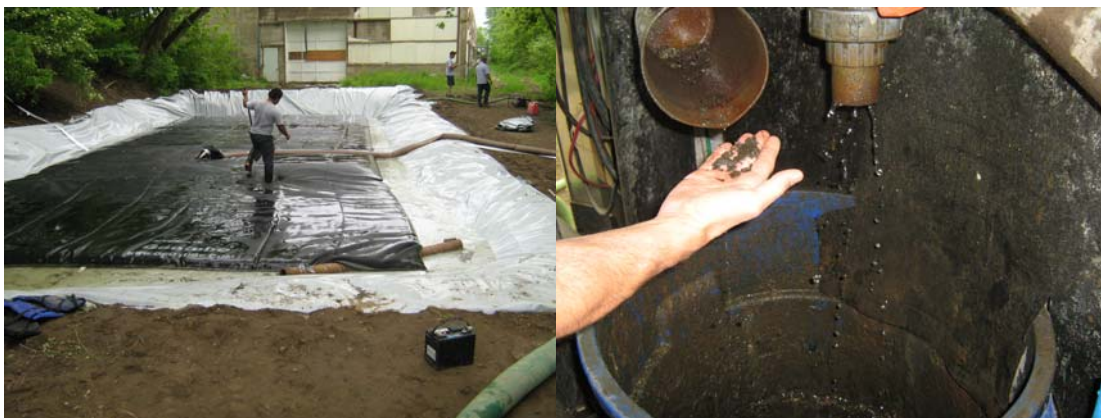
Photo 5 Sac Géotube® et exemple du floc obtenu par la polymérisation
