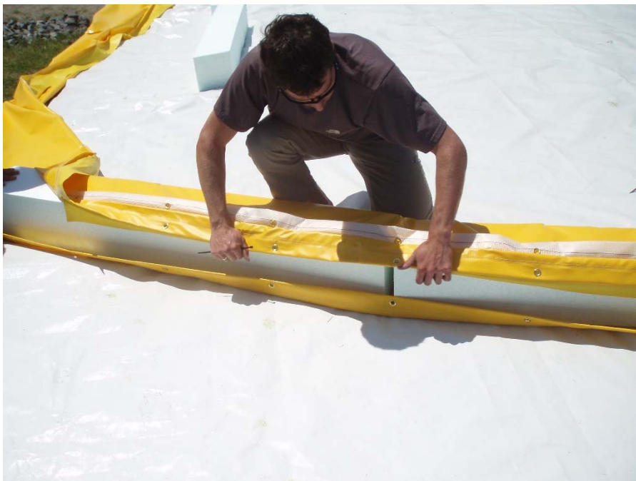
Photo 6 : Montage de l'anneau de flottaison
