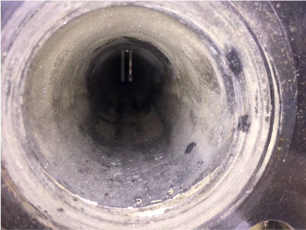
Photo du débitmètre de St-Flavien lors de l'inspection du 18 octobre 2017
