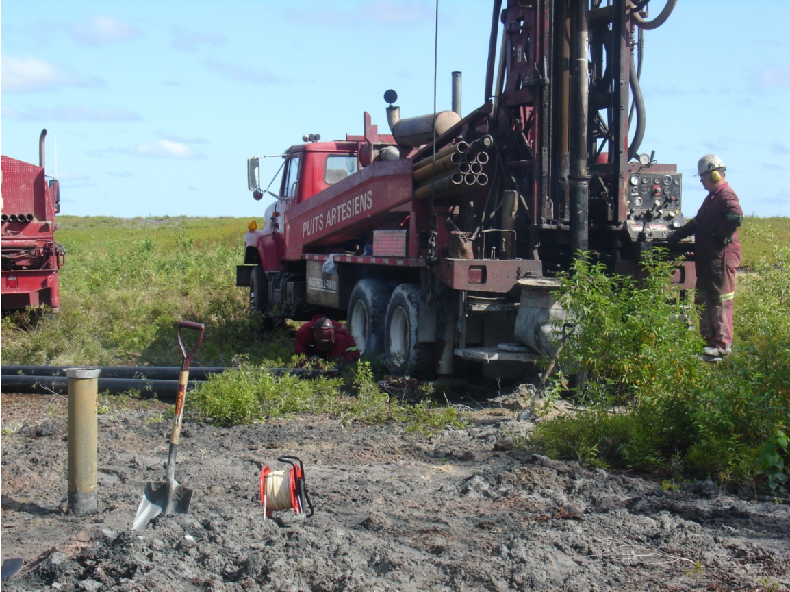
Photo 2-6 : Forage destructif et installation de piézomètres (à gauche de la photo) dans le secteur de Saint-Félicien, arrondissement de Saint-Méthode.
