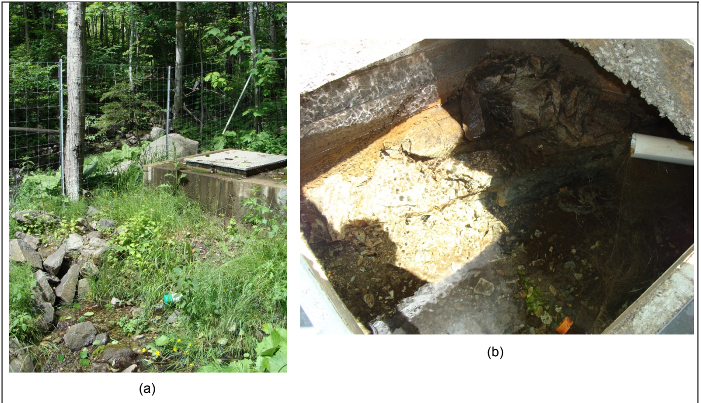
Figure 7-2 : Installation de captage de la résurgence dans un caisson de béton (a) et vue de l'intérieur du caisson avec les tuyaux d'amenés d'eau (b).
