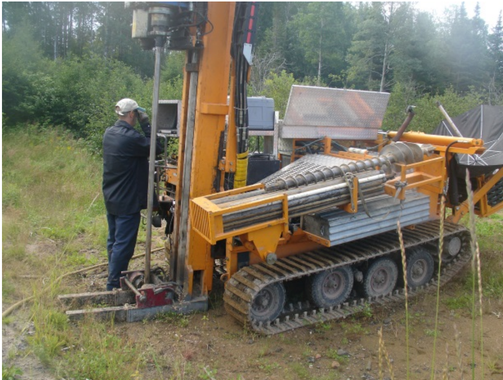
Figure 2-5 : Foreuse Geotech 605D en opération.
