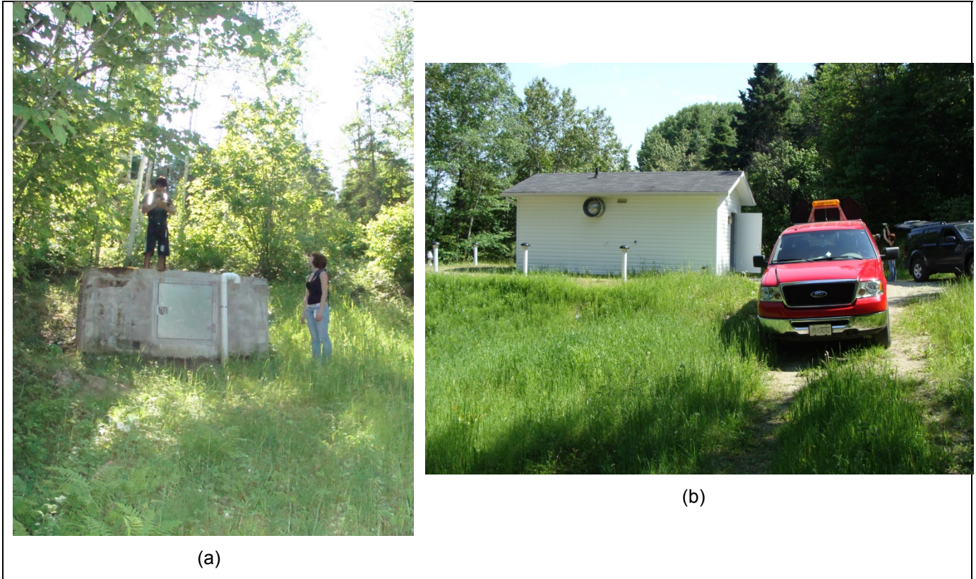
Figure 7-3 : Captage de résurgences à Saint-Urbain; a) exemple de caisson de béton qui confine l'eau de résurgence avant qu'elle soit acheminée vers la station de distribution (b) quelques mètres plus bas.
