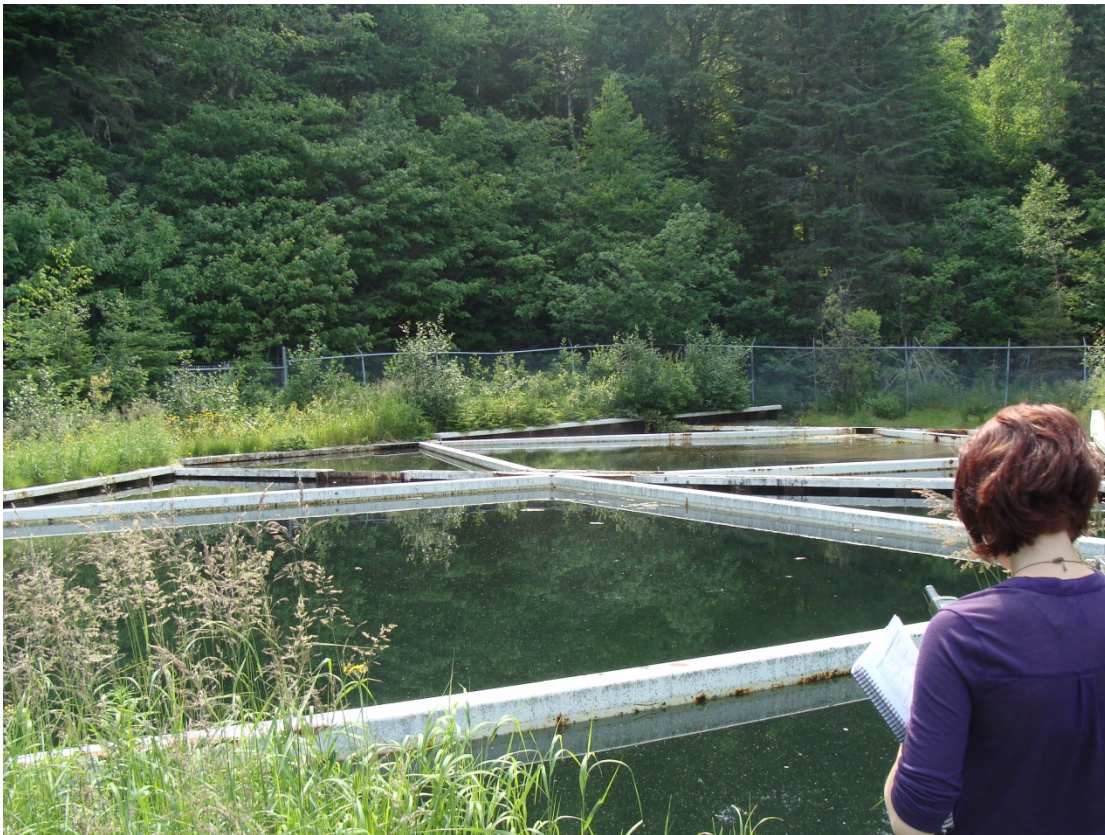
Figure 7-5 : Vue des bassins de captage de l'eau de résurgence à Forestville. Les poutres installées en surface servent à diminuer la vitesse d'écoulement de l'eau.
